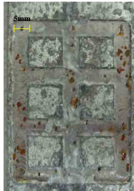
Fotografia 48 - Corpo-de-prova 14 - área exposta 1080mm 2 com a presença de pontos de oxidação
