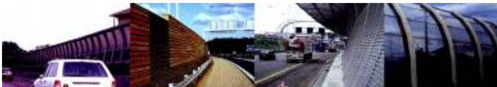
Figura 42 Fotos de barreiras acústicas urbanas.
